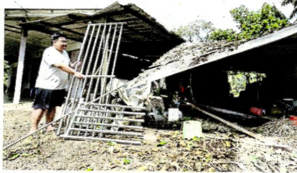
PENDUDUK , Lee Kim Guan, 41, menunjukkan sebahagian bumbung garaj rumahnya yang rosak dihempap dahan pokok dalam kejadian hujan lebat dan ribut petir di Bertam, Malim.
